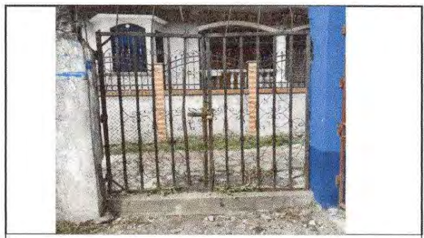
FOTO 11: Fabricación e instalación de portón de metal de ingreso
