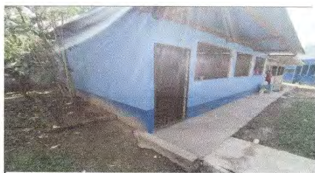
FOTO 5: Pintura en muros exteriores e interiores
