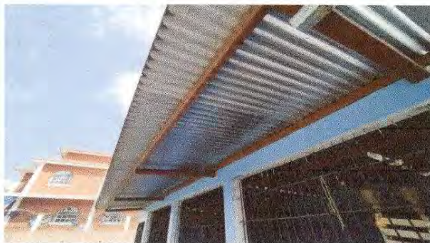
FOTO 3: Sustrucción de canal de metal
