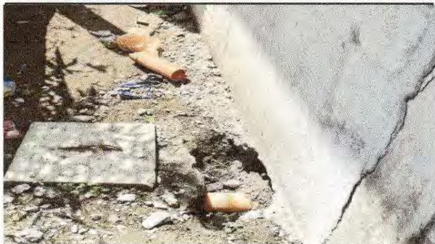
FOTO 7: Sustrución de caja de registro
