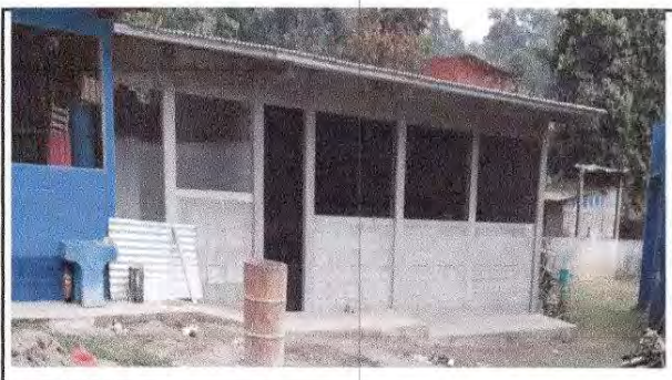
FOTO 10: Repello en muro
