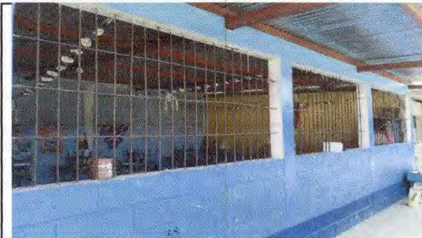
FOTO 8: Fabricación e instalación de balcones de hierro en ventana
