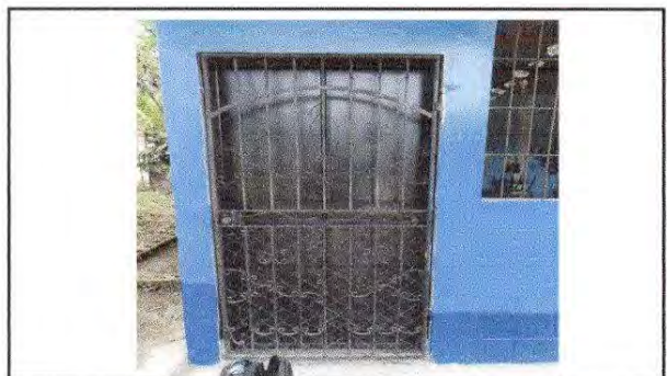
FOTO 9: Fabricación e instalación de puertas de metal en módulos
