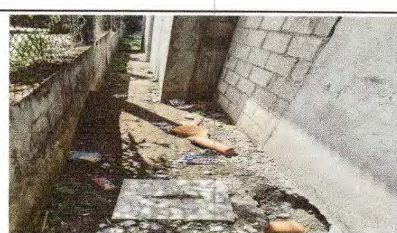
FOTO 6: Sustrucción de tubería PVC línea principal aguas negras
