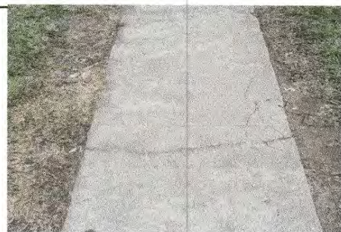
FOTO 4: Reparación de banquetas de concreto
